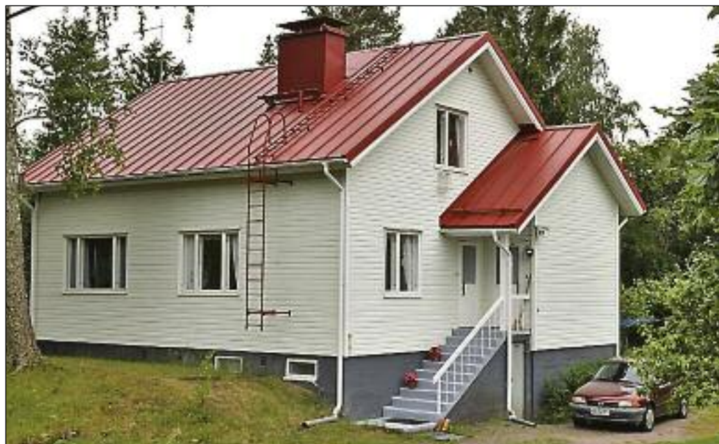
Lávky a žebříky Ruukki zajišťují přístup pro údržbu komínů.
